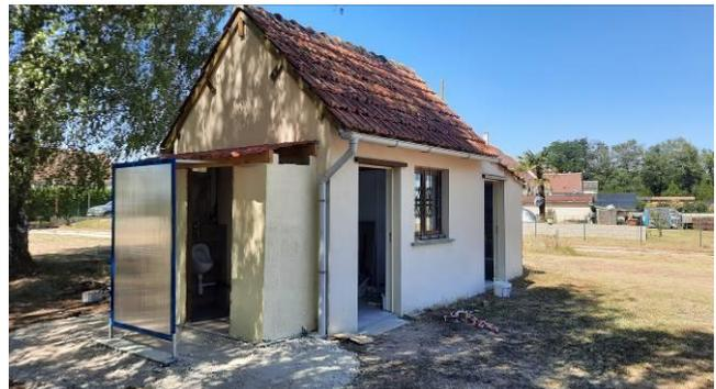
Il s'agit d'une « vespasienne », édicule inventé par le comte de Rambuteau (préfet de Paris en 1834). Nos sanitaires devenant insuffisants lors de nos journées de circulation, nous avons décidé de construire un petit local en utilisant des plaques de béton provenant de la guérite SNCF récupérée à Saint-Amand-Longpré, et en installant 2 urinoirs.
